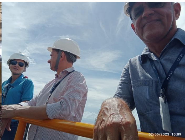
Engenheira lanca detalhando andamento dos trabalhos
