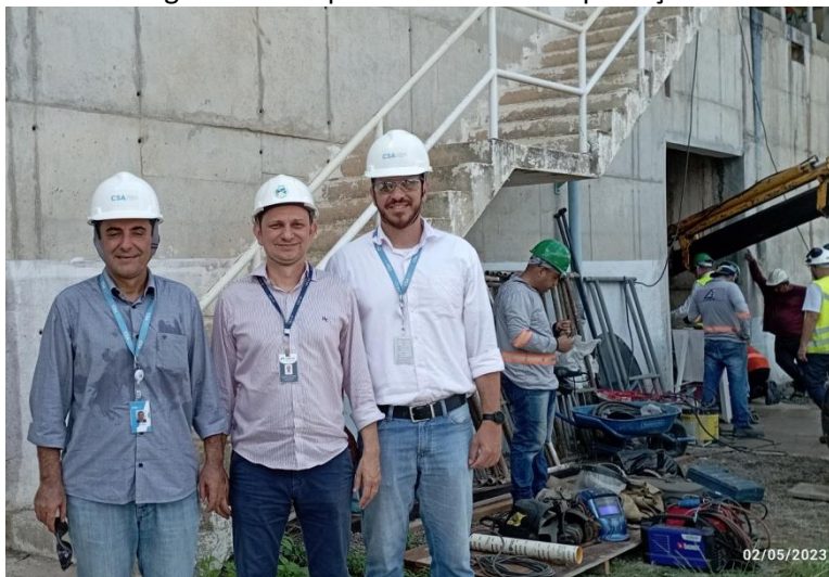
Diretores acompanham instalação da interligação das ETA's
