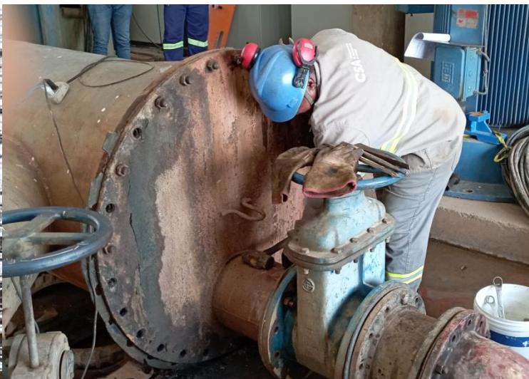
Reparo do ultimo vazamento na área de bombas
