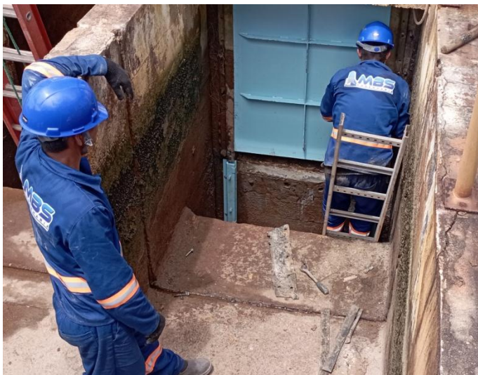
Instalação de comportas de distribuição de água Buta
