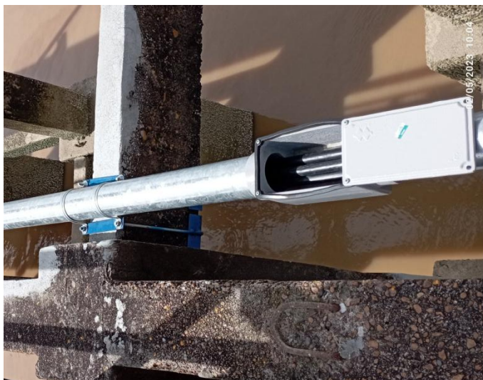
Novo cabeamento de energia da Captação
